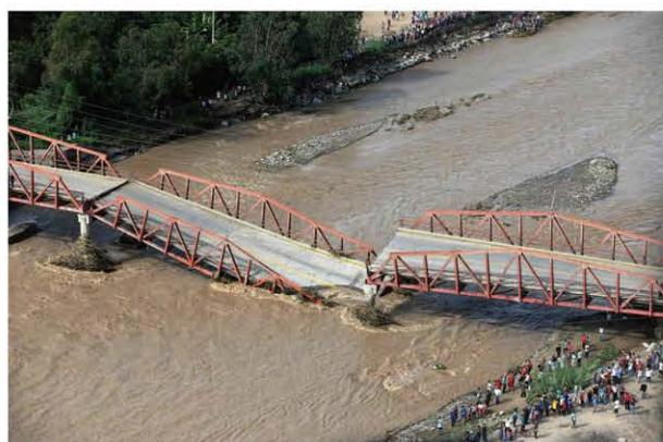
图 4-3-8 2017 年秘鲁沿海地区暴雨引发洪水灾害使多座桥梁断裂
